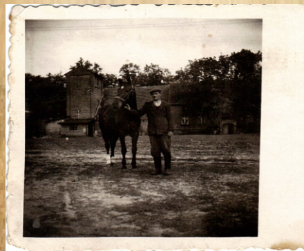
pan Leon Prądziński, wieża ciśnień i dom mieszkalny
