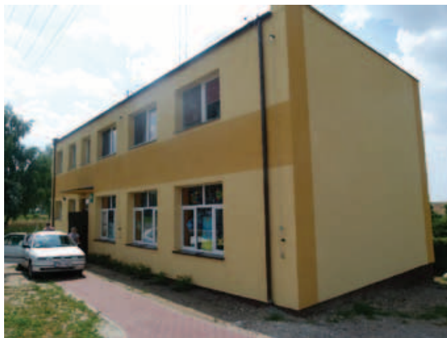
Nowa elewacja świetlicy w Łyskowie.
