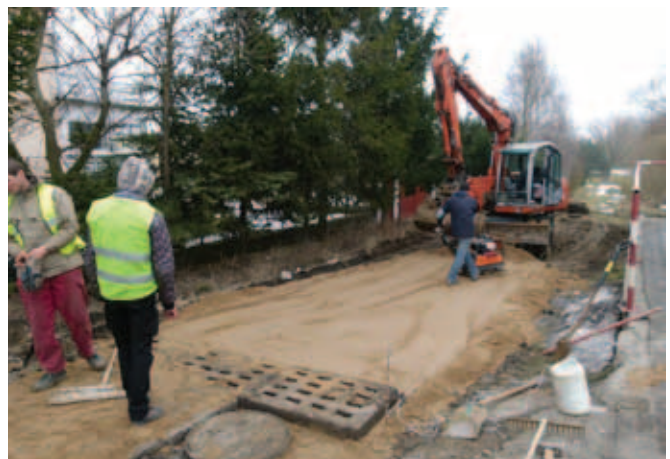
Układanie płyt betonowych na drodze gminnej prowadzącej do posesyjności grodziska „Burchat”
